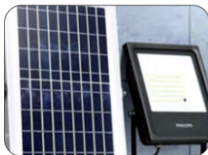
Měření fotovoltaického panelu
